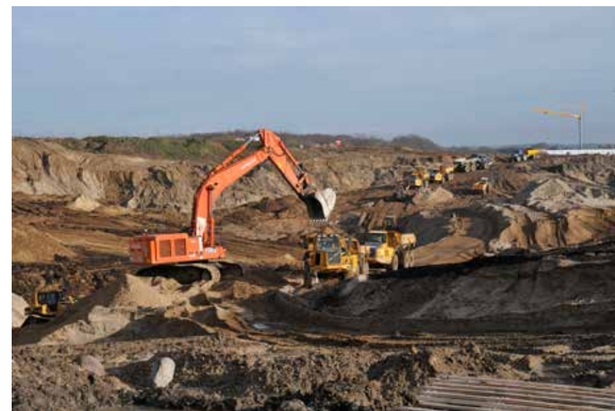
Omvæltninger til ny motorvej ved Søgård - ved den slags anlægsarbejder giver det rigtig god mening at der kræves erstatningsnatur
